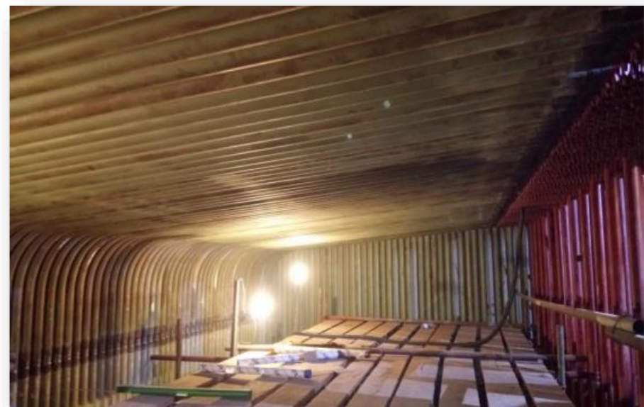
超合金披覆爐管壽命超過10年
