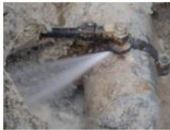
3. การรั่วไหลของสารทำความเย็น
